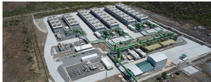
35 MW Sosian Menengai Power Plant, GDC
